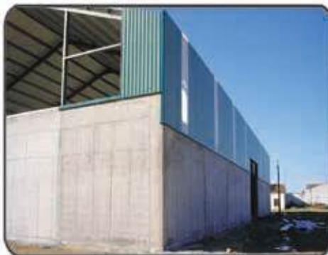
Nave industrial estructura prefabricada hormigón Almacén Agrícola
