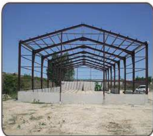
Almacén agrícola estructura metálica
